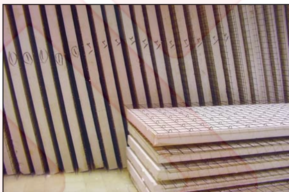
شکل ۴۸ حمل و تخلیه پانل‌ها در محل کارگاه
