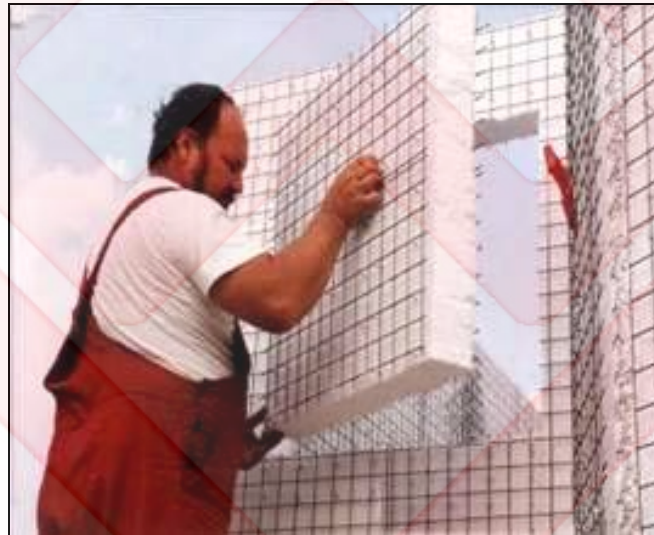
شکل ۳۸ برش و خروج قسمت پیش‌بینی شده برای بازشو
