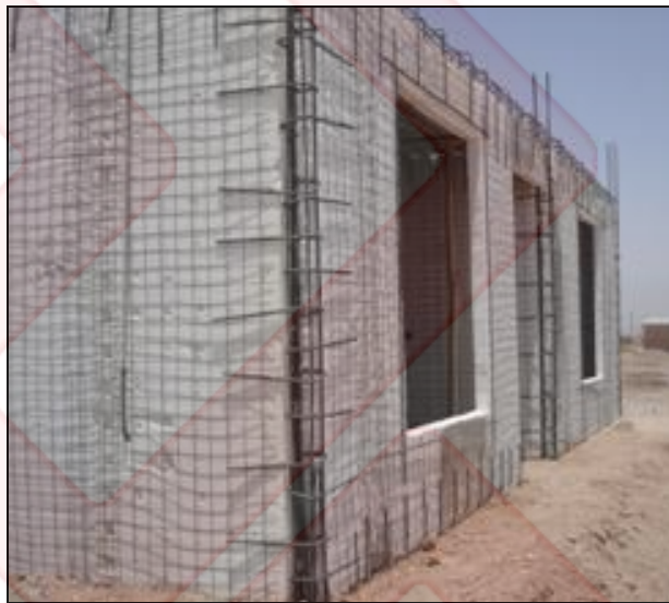
شکل ۲۳ نمونه مقطع افقی، فرم میل‌گردها و نمای کلاف قائم در محل اتصال دو دیوار عمود بر هم
