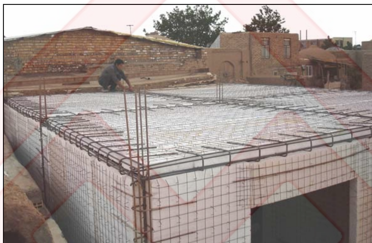
شکل ۷ کلاف‌بندی دیوار و سقف پانل سه‌بعدی
