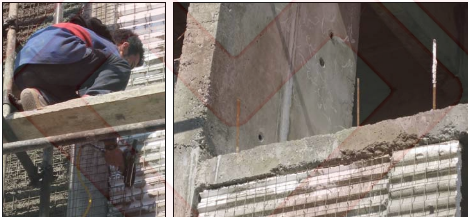
شکل ۱۵ مهار شبکه فلزی پانل 3D با سیم آرماتوربندی به میل‌گردهای انتظار
