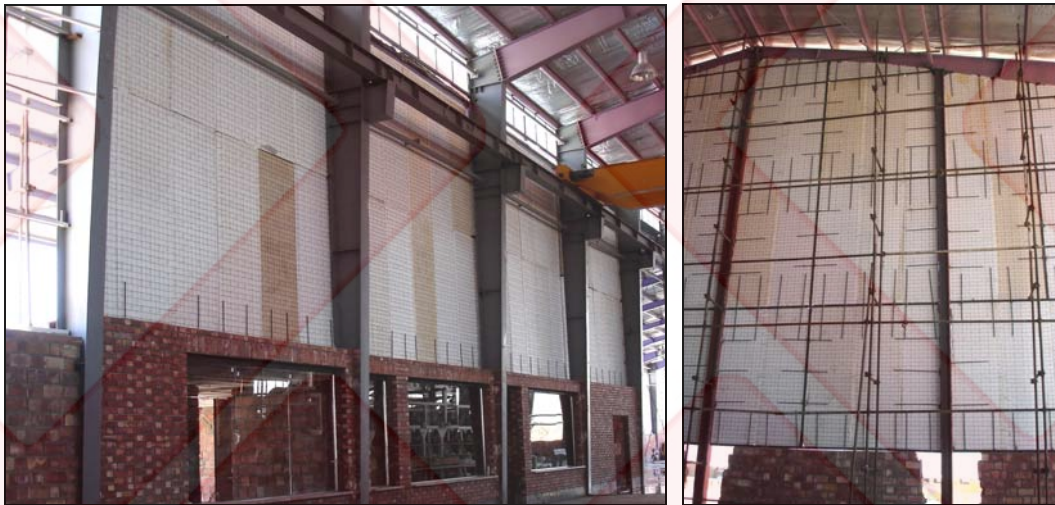
شکل ۲۱ استفاده از تعدادی میل‌گرد در درزهای اتصال برای دستیابی به صلبیت بیشتر (در دیوارهای مرتفع)
