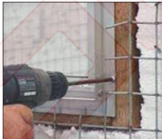
شکل ۳۹ جاگذاری قاب بازشو و تقویت شبکه فلزی
