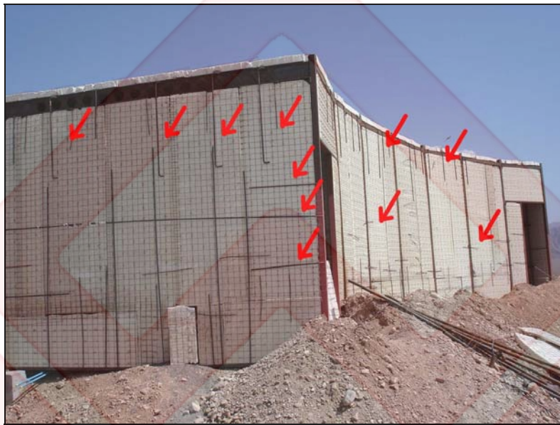
شکل ۱۶ میل‌گردهای انتظار برای اتصال پانل به سازه فلزی ساختمان
