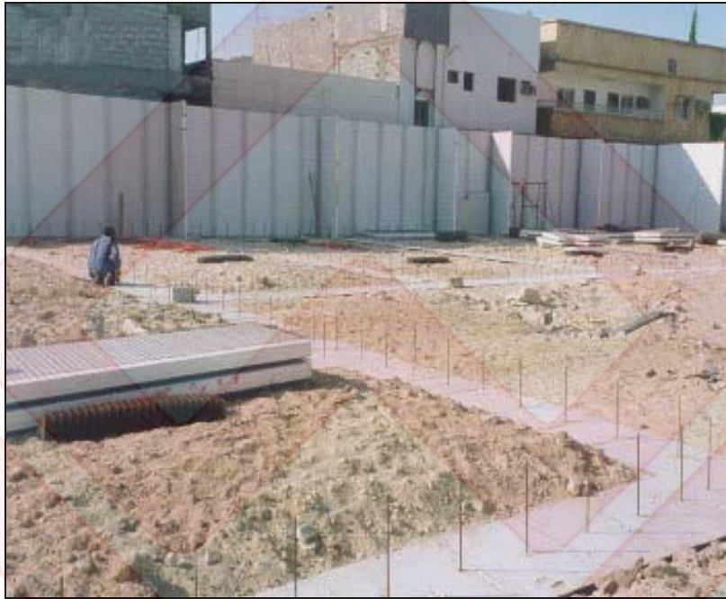
شکل ۳۰ میل‌گردهای انتظار پیش‌بینی شده در شالوده برای ایجاد اتصال به دیوارها
