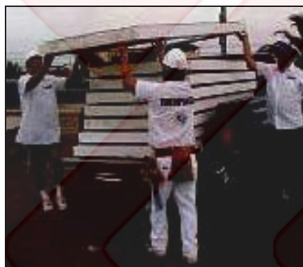
شکل ۴۸ حمل و تخلیه پانل‌ها در محل کارگاه
