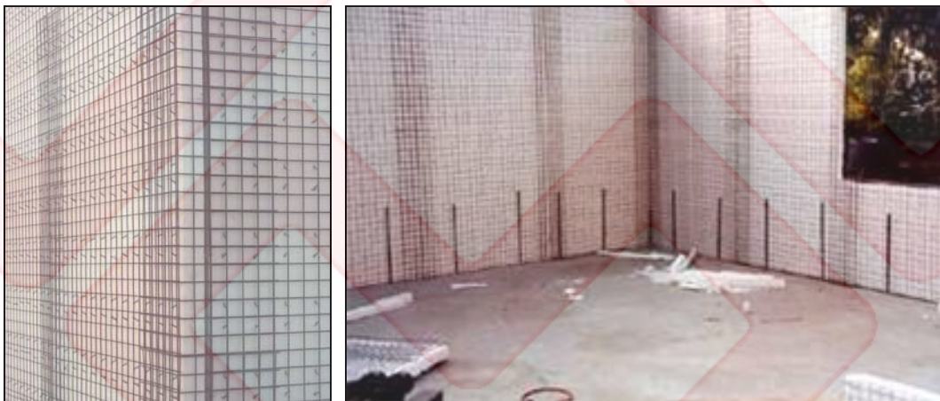
شکل ۱۷ اتصال پانل‌های مجاور به یکدیگر
