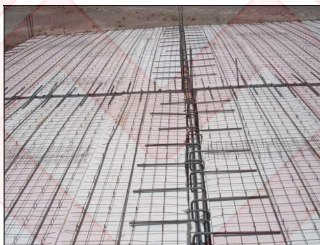
شکل ۳۳ استفاده از میل‌گردهای تقویتی در بالا و زیر سقف برای دهانه‌های بزرگ
