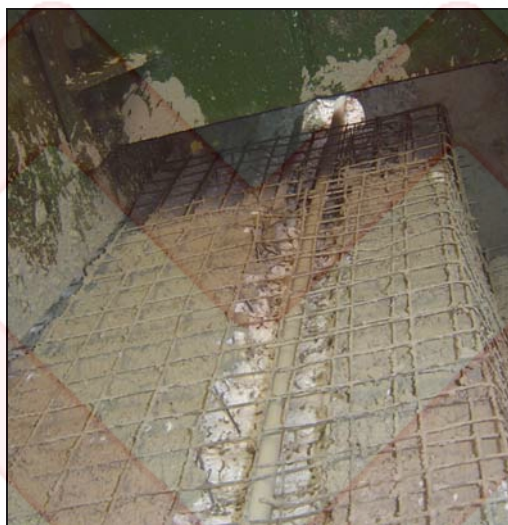
شکل ۶۰ عبور اجزای مکانیکی یا الکتریکی از میان پلی استایرن و از گشودگی افقی بدون ایجاد موانع حریق
