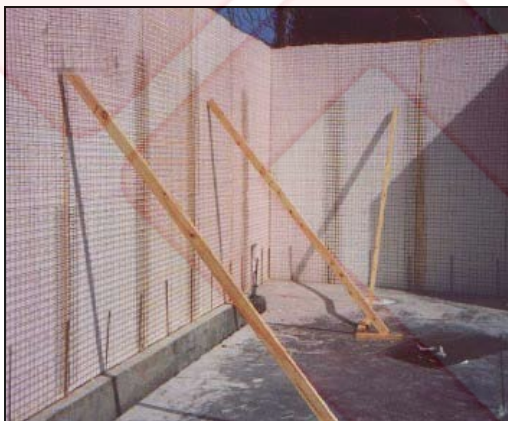
شکل ۳۱ مهارهای جانبی برای استقرار و تثبیت پانل‌ها قبل از بتن‌پاشی
