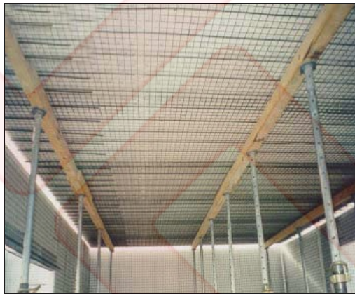
شکل ۳۵ شمع‌بندی انجام‌شده سقف 3D
