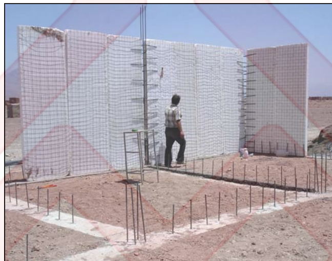
شکل ۸ اتصال به فونداسیون با میل‌گرد انتظار
