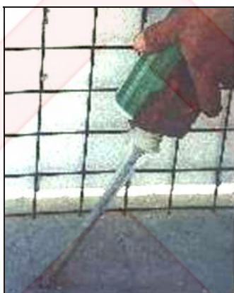
شکل ۹ اتصال به فونداسیون با چسب اپوکسی در فضای خالی غلاف
