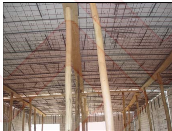
شکل ۳۵ شمع‌بندی انجام‌شده سقف 3D
