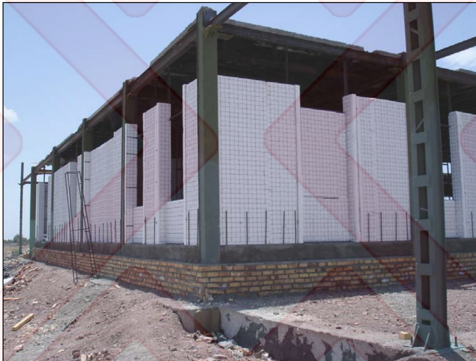
شکل ۱۳ اتصال کف به پانل‌ها توسط میل‌گردهای انتظار در فضای بین پلی استایرن و شبکه فلزی پانل
