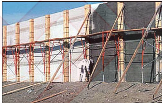
شکل ۳۱ مهارهای جانبی برای استقرار و تثبیت پانل‌ها قبل از بتن‌پاشی
