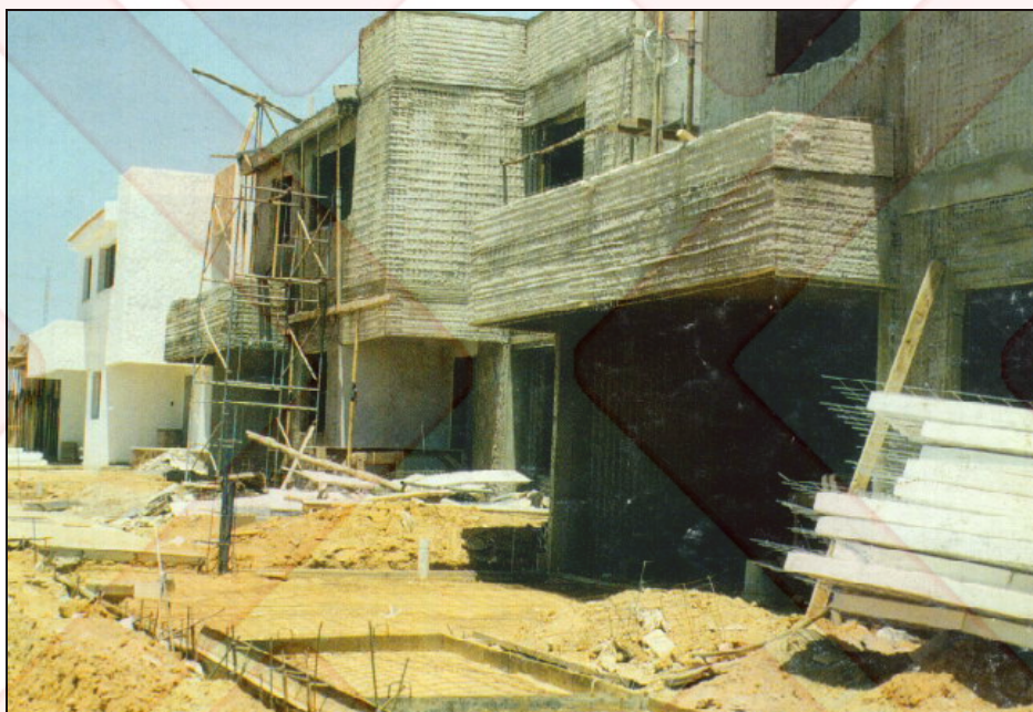
شکل ۲ ساختمان در حال ساخت با پانل‌های نیمه‌پیش‌ساخته سه‌بعدی
